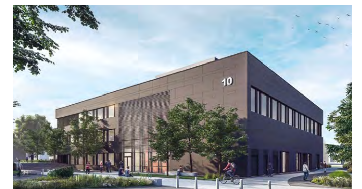
Das neue Laborgebäude für den Fachbereich Elektrotechnik und Technische Informatik sowie für den Fachbereich Maschinenbau und Mechatronik.
