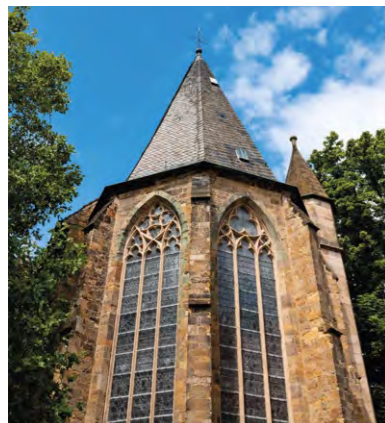
Auch die Fassade sowie das Turmkreuz in 28 Metern Höhe wurden restauriert.
