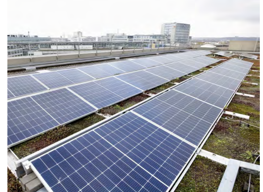
Solarmodule auf dem Dach versorgen Land- und Amtsgericht Düsseldorf künftig mit bis zu 180.000 Kilowattstunden umweltfreundlichem Strom.
