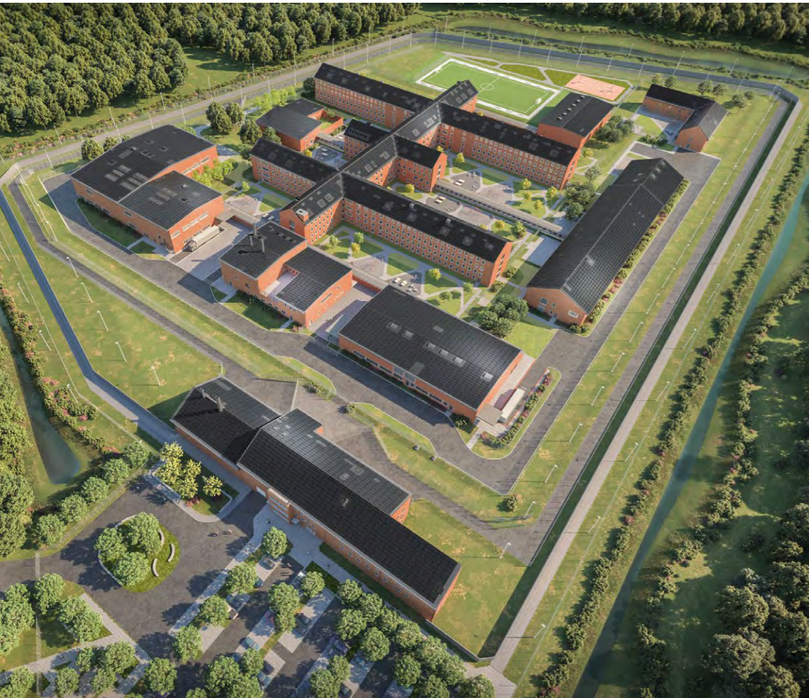
Die neue JVA Münster wird auch jede Menge grüne Energie spenden. Alle Gebäude werden mit Photovoltaik-Modulen ausgestattet. Gesamtleistung: über 4 Megawatt Peak.
