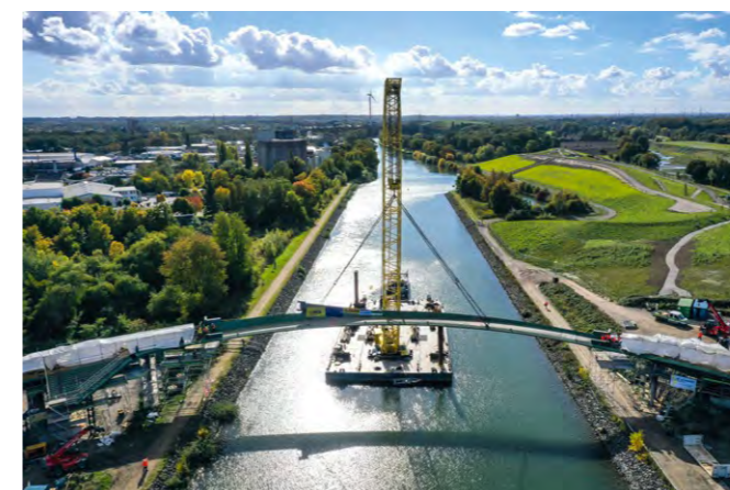
Neben dem militärischen und dem zivilen Bundesbau bildet der sogenannte Zuwendungsbau das dritte Tätigkeitsfeld des Bundesbaus NRW. Ein Beispiel ist etwa die Begleitung des Brückenbaus „Emschersprung“.
