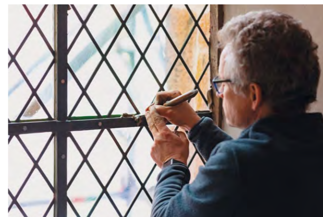
Per Hand haben die Kunstglaser die Scheiben mit Spezialkitt akribisch ausgebessert und abgedichtet.
