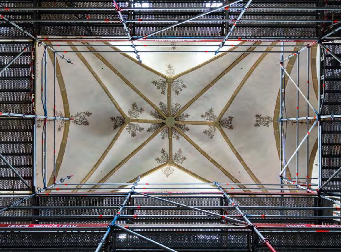
Gerüstelemente, so weit das Auge reicht: Über die ausgefeilte Konstruktion aus Hunderten Stahlstangen und Holzbohlen gelangen die Handwerkerinnen und Handwerker an jeden einzelnen Punkt der Kirche.
