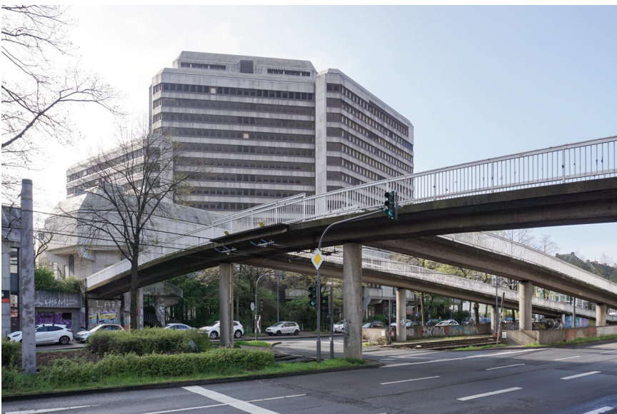
oben: Fußgängerbrücken im Bereich Luxemburger Straße / Stadtbahn-Haltestelle und Justizzentrum
