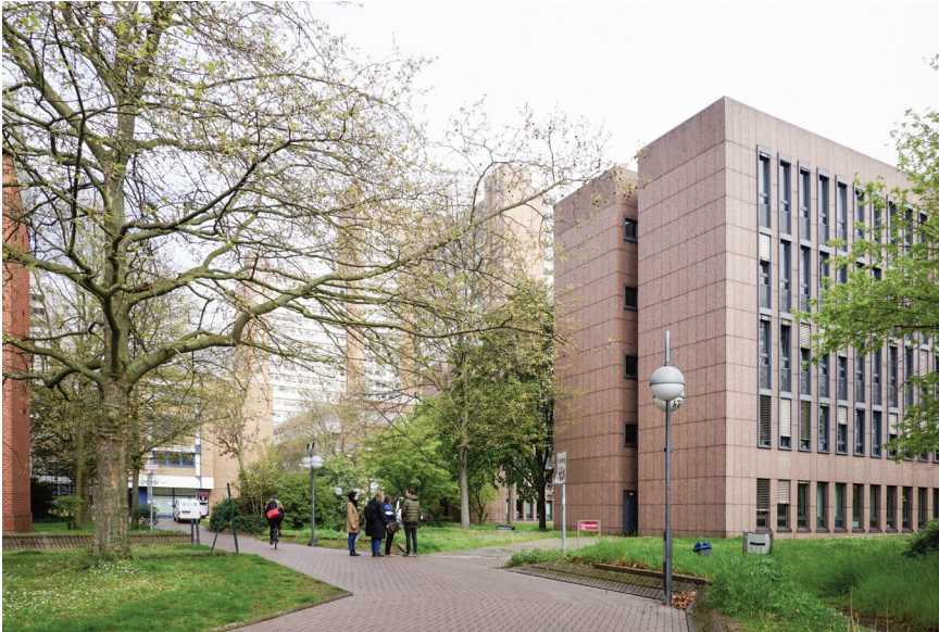
oben: Innere Freiräume im Justizzentrum - Blick auf das Gebäude der Staatsanwaltschaft
