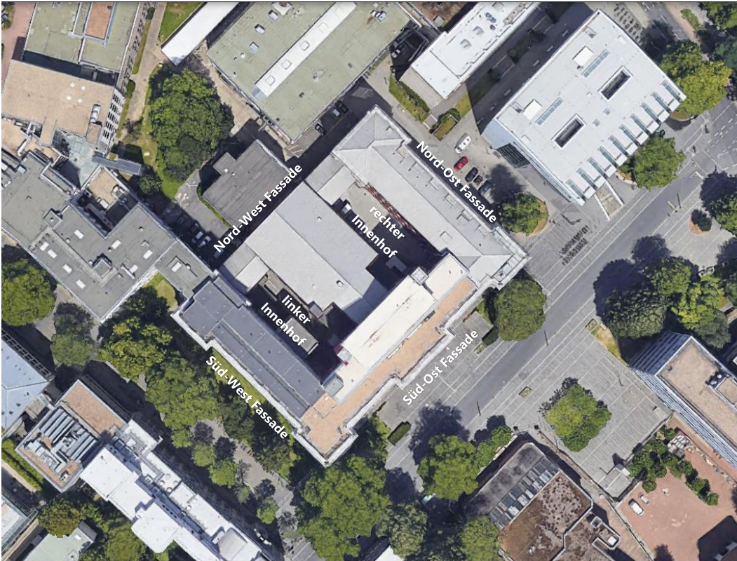
Luftbild von dem Hauptgebäude mit Kennzeichnung der Fassaden (Quelle: earth.google.de)
