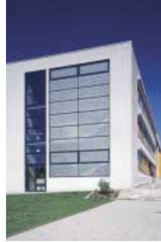
Fachhochschule Gelsenkirchen, Abteilung Recklinghausen Ayse Erkmen, Namenstafel , 1999
