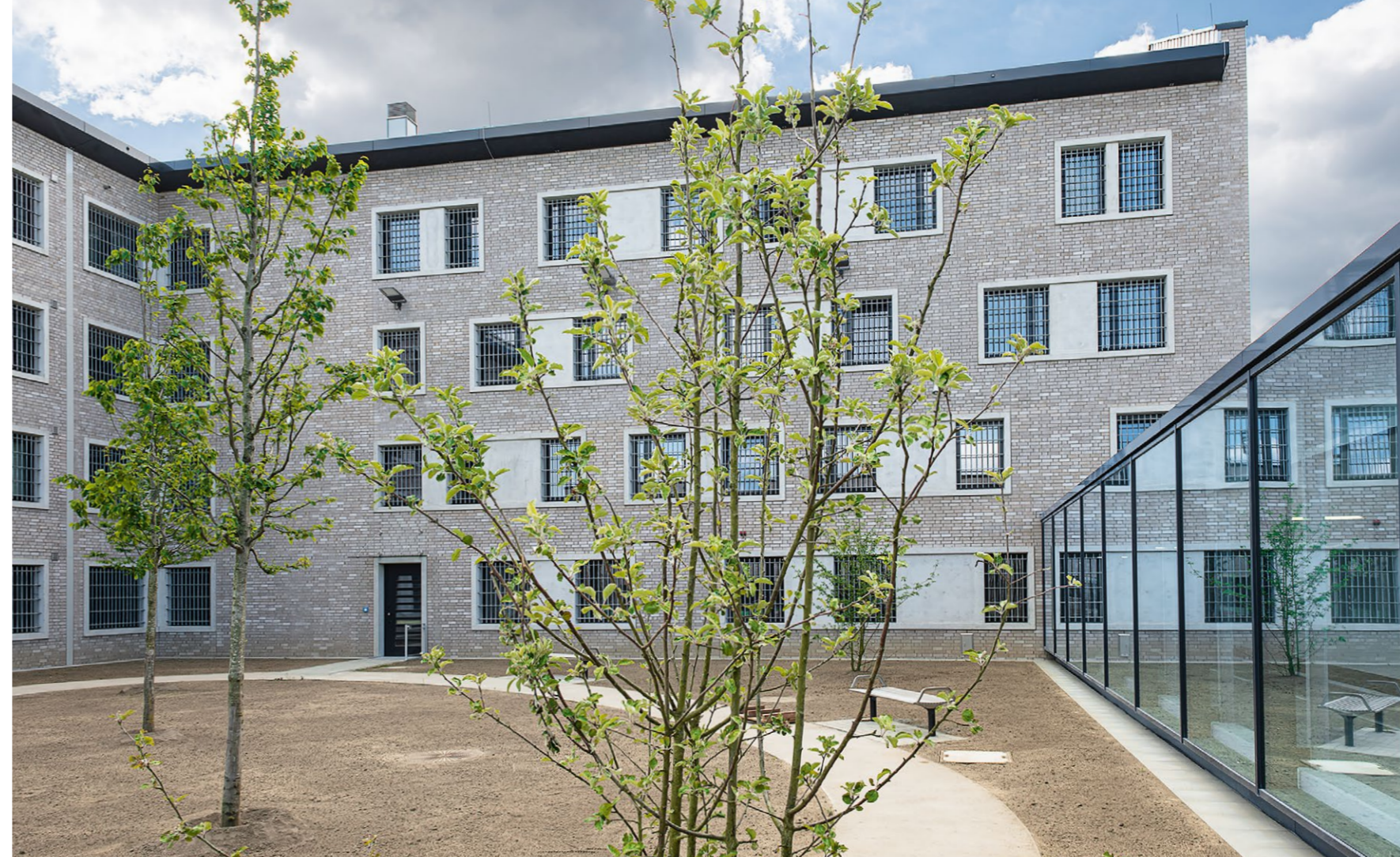
Zwischen den Gebäuden und dem gläsernen Verbindungsgang befinden sich kleine Innenhöfe mit Bepflanzung.
