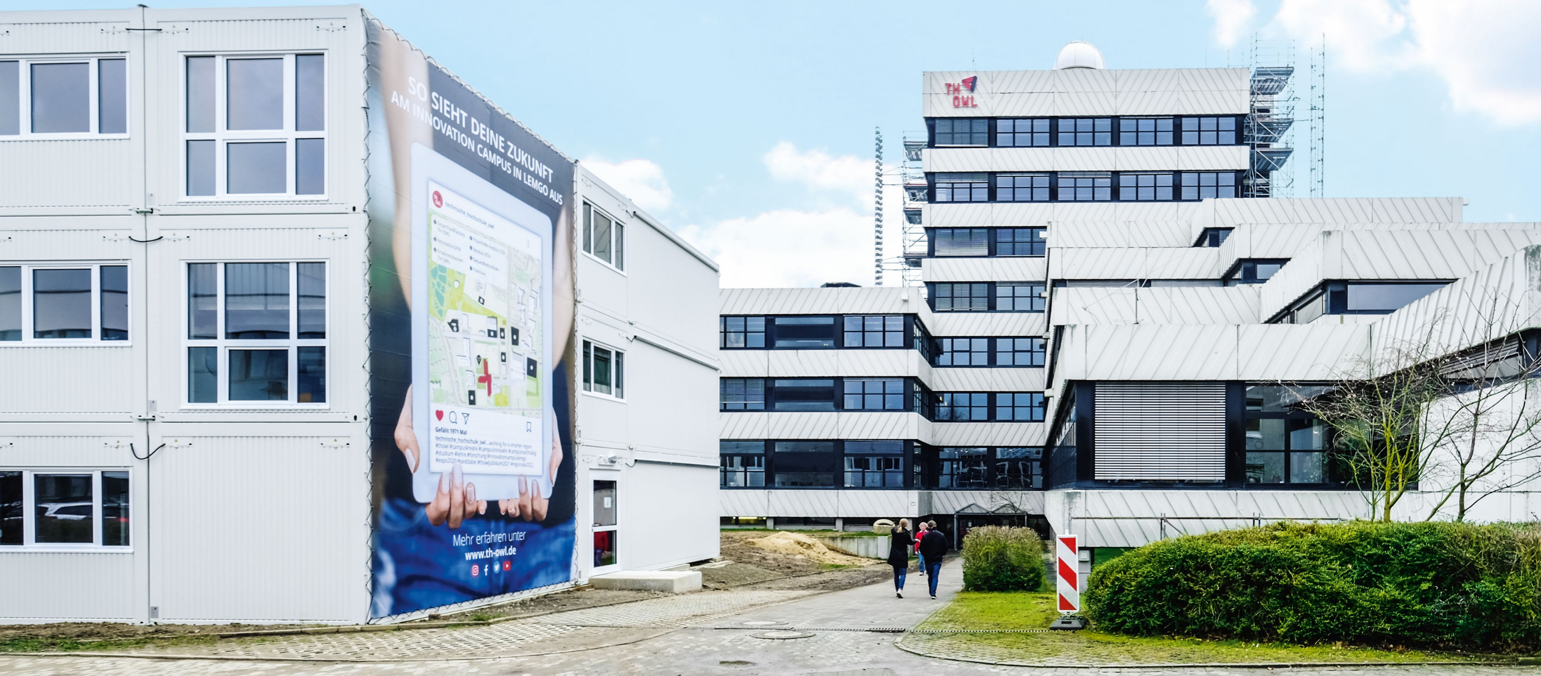
Bei der Errichtung des Interimsgebäudes (links im Bild) hat der BLB NRW auf die denkmalschutzrechtlichen Besonderheiten des Lemgoer Hochschulgebäudes (rechts und hinten im Bild) Rücksicht genommen.
