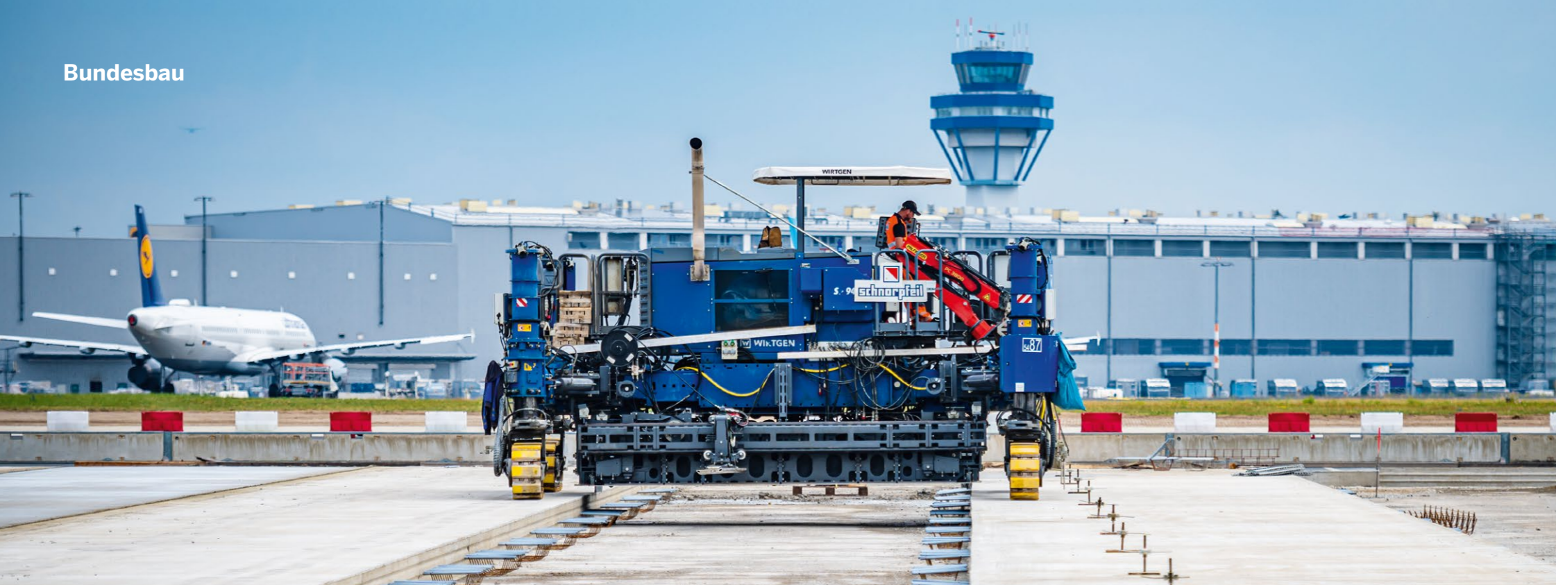
Hochpräzise wird die 38 cm starke Betondecke im Zeitlupentempo auf dem vorbereiteten Unterbau aufgebracht.
