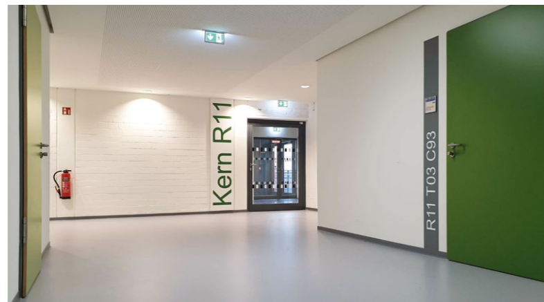
Die sanierten Flächen sind hell und modern. Hinten rechts erkennt man den Durchbruch zu den neu geschaffenen Fluchttreppen.
