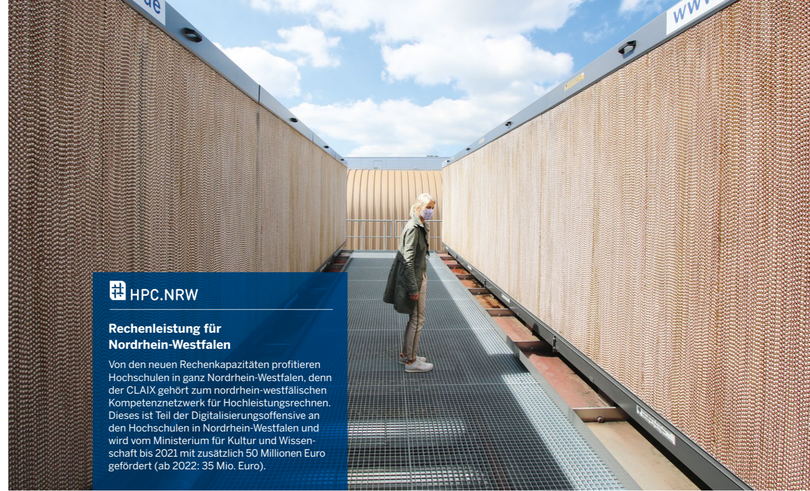
Der Befeuchterkörper der Kühlwerke sieht nicht nur so aus, sondern ist tatsächlich aus Wellpappe.
