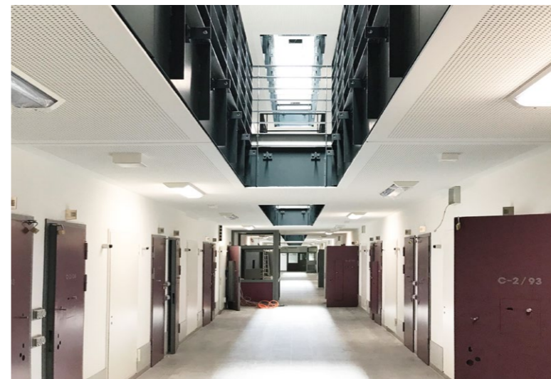
Blick in den neuen Zellenblock.
