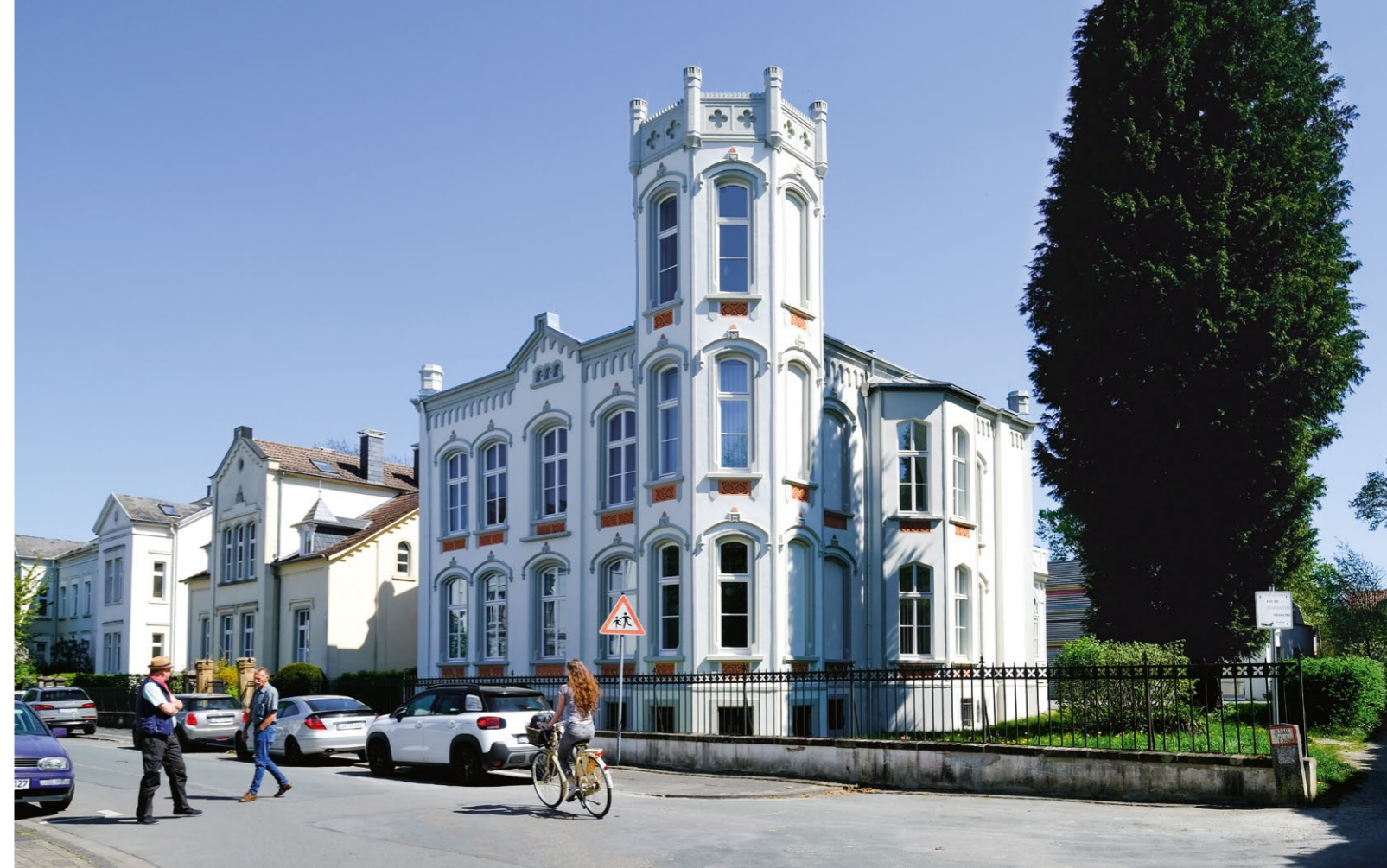
Die Villa Gartenstraße gehört zur Hochschule für Musik in Detmold und wurde ebenfalls aufwendig restauriert.
