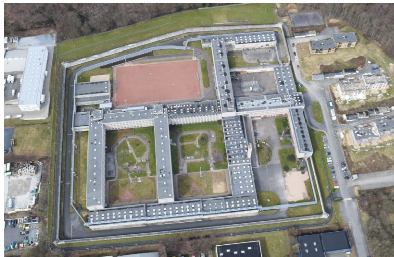
Vor dem Start der Erweiterungsarbeiten – rechts, außerhalb der JVA-Mauer, sind noch die mittlerweile abgerissenen Dienstwohnungen zu erkennen.
