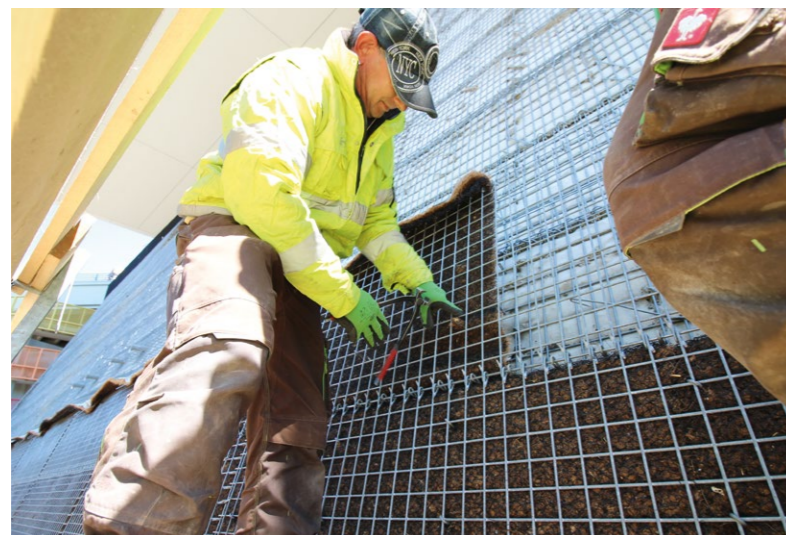
Vor den Gabionen (Drahtschotterkörben) werden Kokosmatten angebracht. Sie enthalten Samen, die in kürzester Zeit keimen und die Stützmauer begrünen.
