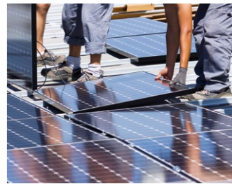
Mit Rückendeckung des Landeskabinetts wird der BLB NRW in Zukunft verstärkt Photovoltaikanlagen auf seinen Liegenschaften installieren.
