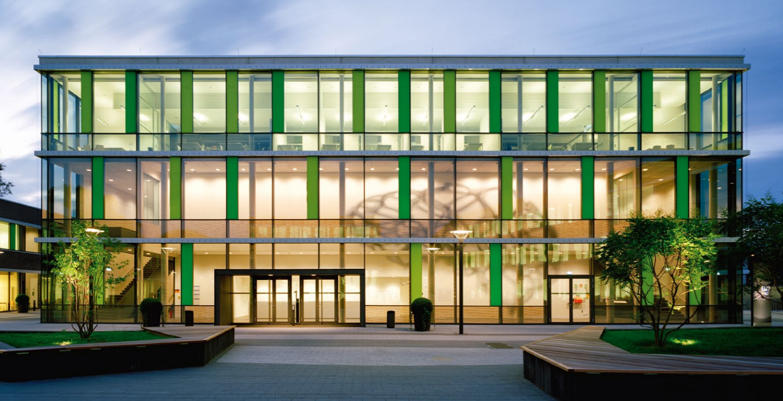
Die hochtechnisierten Gebäude auf dem grünen Campus der Hochschule Rhein-Waal in Kamp-Lintfort sind ein Beispiel für nachhaltiges Bauen und überzeugen mit niedrigen Betriebskosten.
