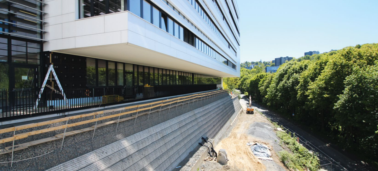
Die Gebäude V und W stehen auf der „Bewehrten Erde“. Gut zu erkennen: die Betonauffüllung unten am Sockel und die übereinander gestapelten Gabionen (siehe Grafik rechts).
