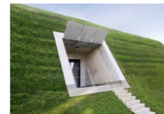
Übrigens: Auch bei der Anlage der Erdabschirmung am SoN (vgl. Seite 32) kam die Bewehrte Erde zum Einsatz.
