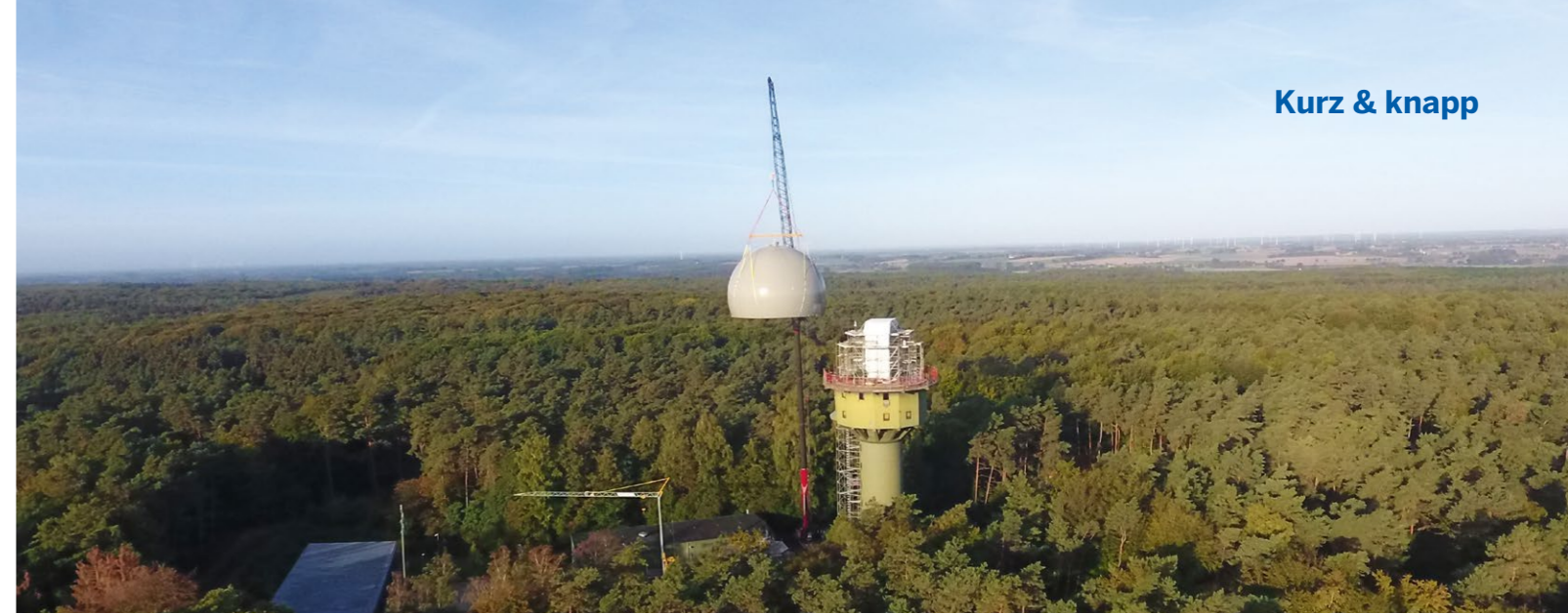
Die neue Radarkuppel wurde am Boden zusammengebaut und anschließend per Kran auf die Plattform gehoben.
