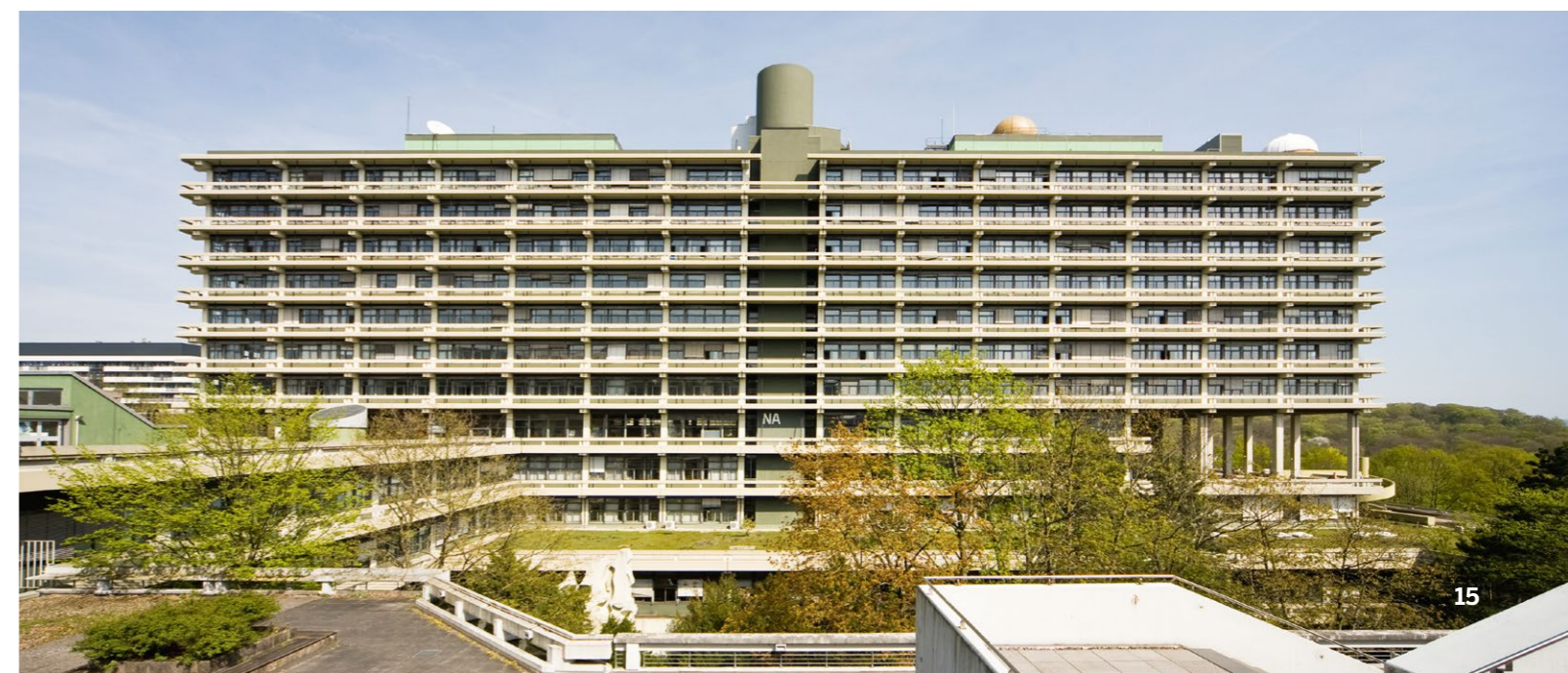
Gebäude NA Ein einheitliches Rastermaß und die serielle Herstellung der Betonteile beschleunigten den Bau der Uni.
