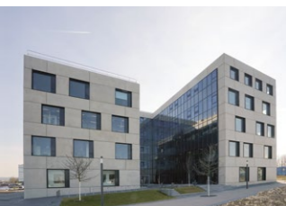
Das CDPP – der erste BIM-Bau des BLB NRW BIM kam beim BLB NRW erstmals 2015 beim Bau des CDPP an der RWTH Aachen zum Einsatz und wurde hier von einem Auftragnehmer erprobt. Von den Erfahrungen konnten am Ende alle profitieren.
