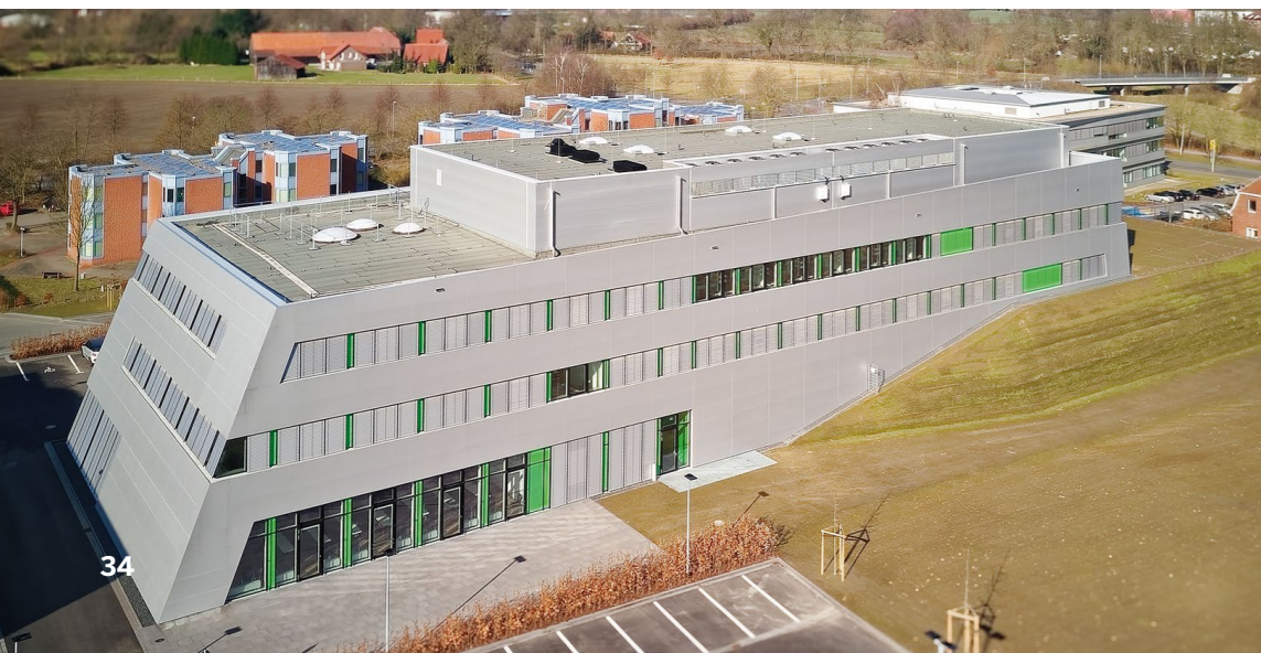
Das SoN von außen. Rechts ist die Erdabschirmung des Mikroskopiebereichs gut zu erkennen.
