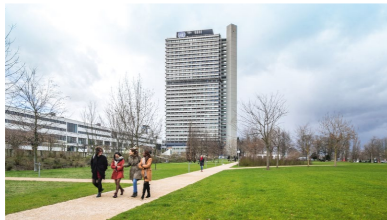
Das ehemalige Abgeordnetenhochhaus entstand von 1966 bis 1969. Der BLB NRW erledigt regelmäßig Maßnahmen zur Bauunterhaltung.
