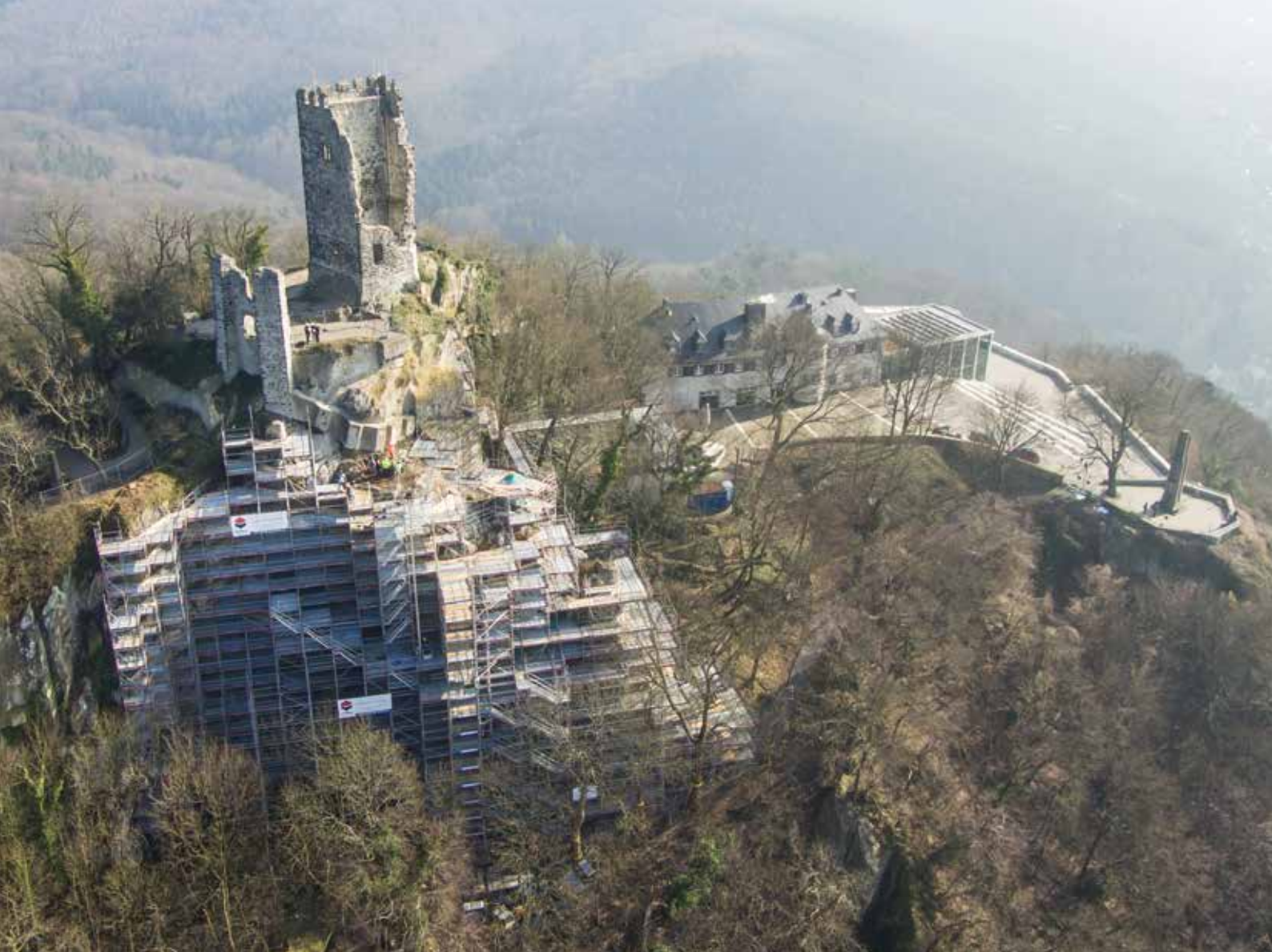
Sanierung Drachenfels, Königswinter
